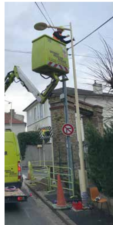
Installation des candélabres
