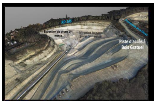
Carrière PLACO – Bois Lecomte avant la fin d'exploitation
